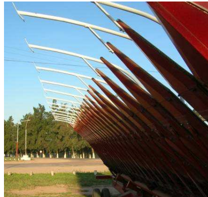
Figura 2. Ganchos improvisados que traen más problemas que soluciones.
