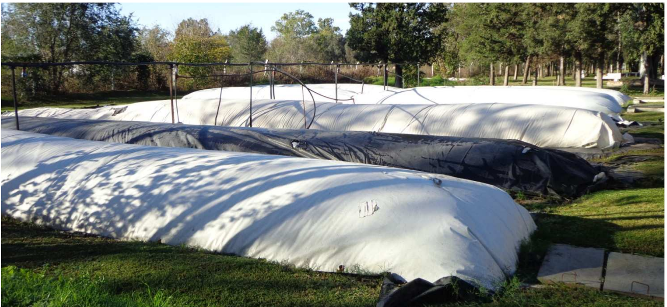
Figura 1: Biodigestores del Mercado San Miguel de Silo Bolsa
