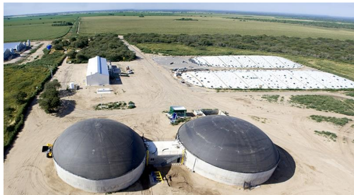
Imagen 2. Silos de maíz planta entera (superior derecha), Sala de generación (superior izquierda), Digestores (inferior).
