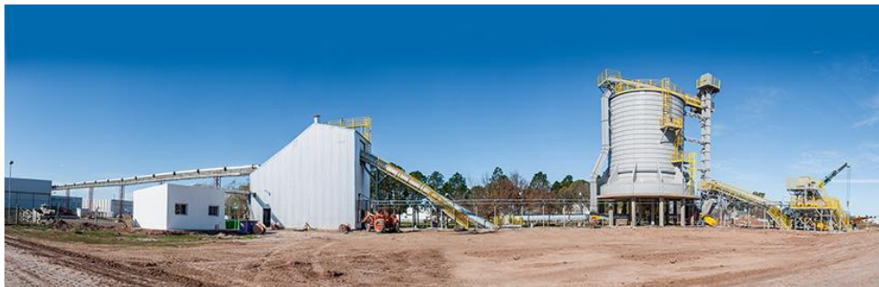
Imagen 4. Silo de biomasa (derecha) y gasificador (centro).
