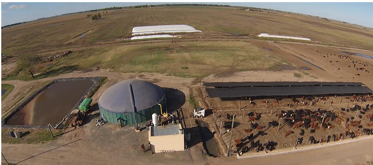
Imagen 3. Vista de corrales de hormigón (derecha), del digestor y sala de control (centro) y de laguna de digerido (izquierda). Fuente: Revista Chacra.
