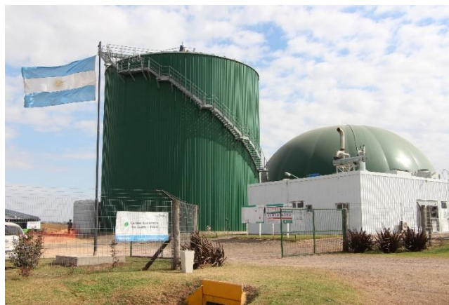
Imagen 1. Vistas del digestor primario (izq.) y del digestor secundario(der.).
